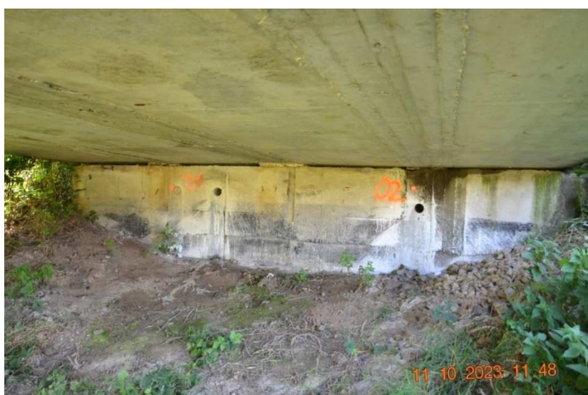
Opěra 1 pravobřežní s vývrty D = 100 mm do úkožného prahu a do dříku v nejvíce potečeném místě opěry.
