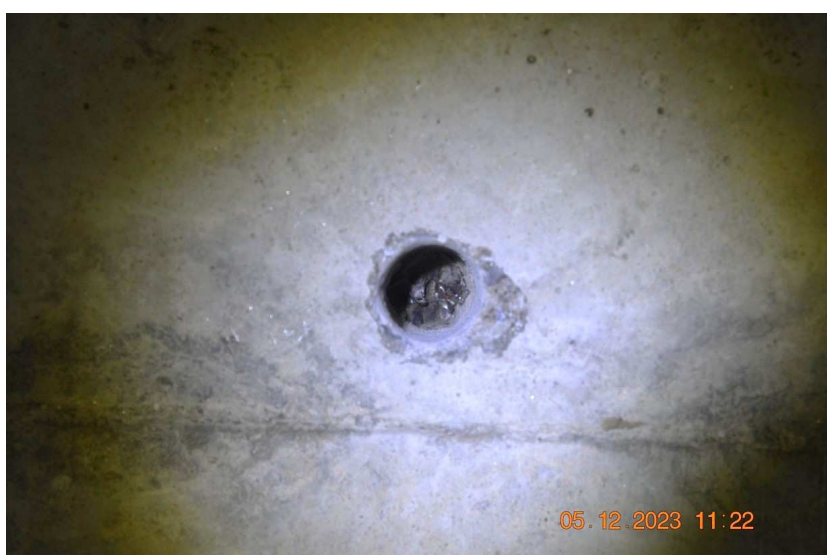
Sondy k předpínací výztuži ve středním poli – kanálky bez koroze a zainjektované.
