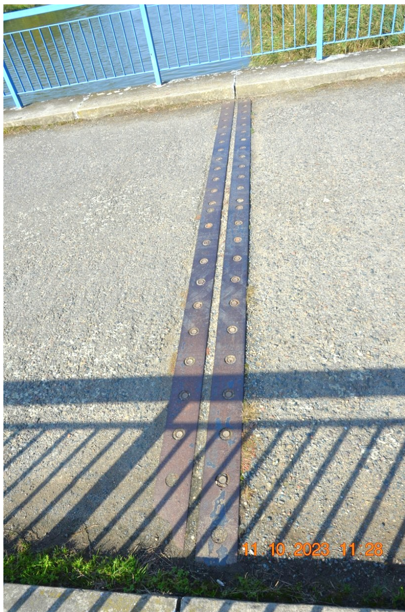
Závěr nad pilířem P3 – u levého břehu.
