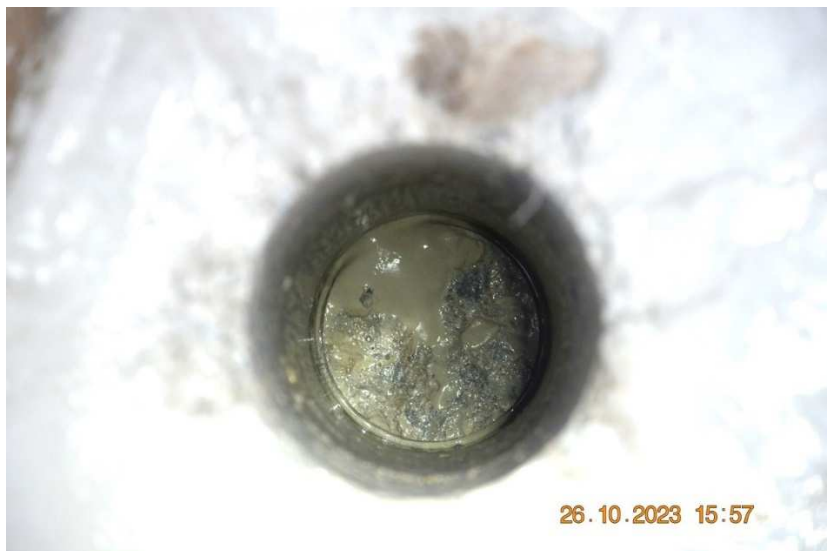
Vývrt H2 ve středu rozpětí středního pole na povodní straně včetně konstrukce vozovky.
