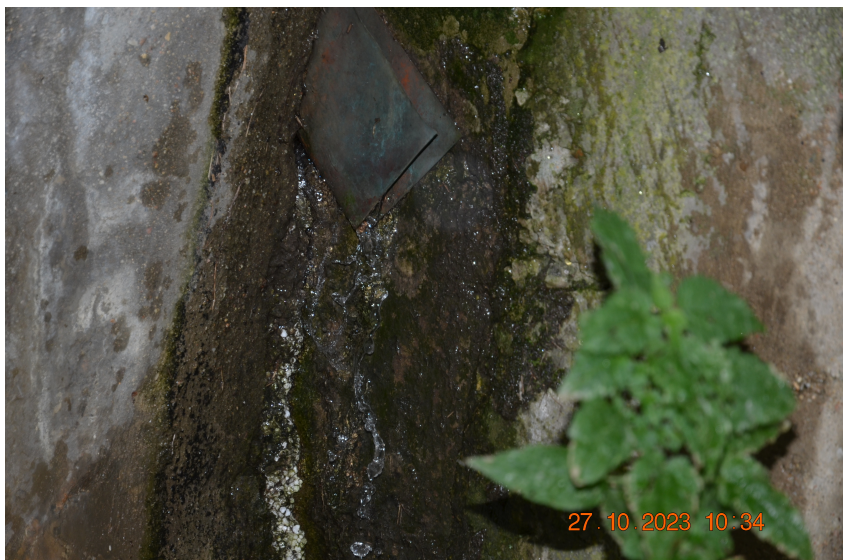
Stékání vody z předchozí fotky po líci opěry 1.
