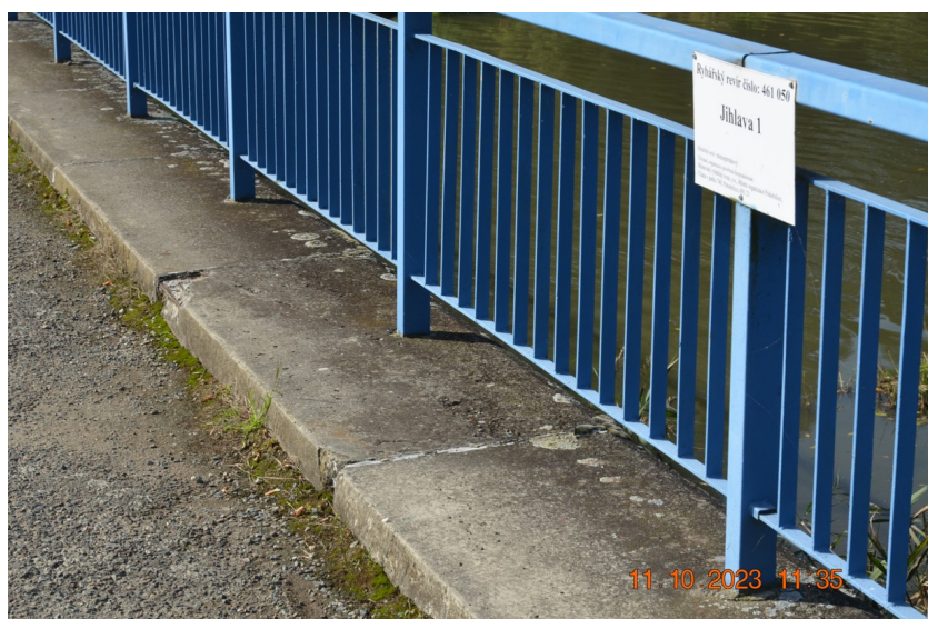
Římky jsou vyskládány z prefabrikovaných dílců.
