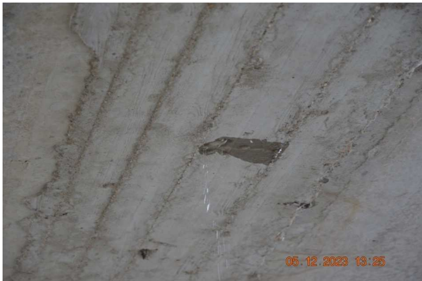
2. pole na návodní straně, z krajní dutiny vytéká po navrtávce voda – detail z předchozí fotky.
