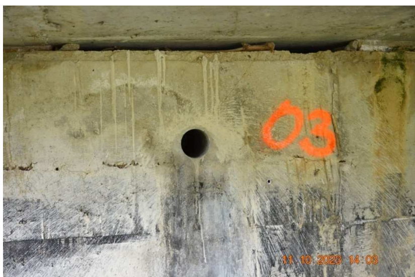
Opěra 4 levobřežní, vývrt do úložného prahu s výztuží.
