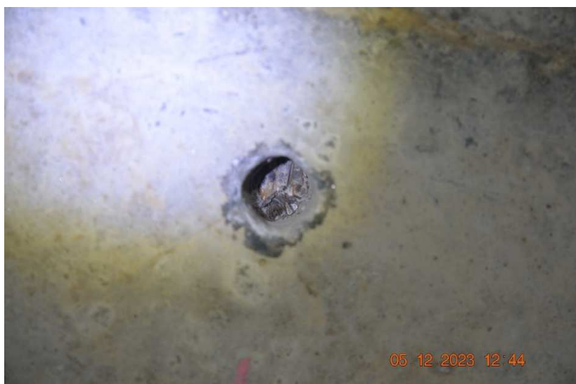
Sonda k předpínací výztuži ve 3. poli (u levého břehu) – kanálky bez koroze a zainjektované.
