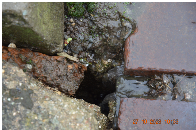
Detail dilatace z předchozí fotky při dešti. Voda teče přímo na opěru 1.
