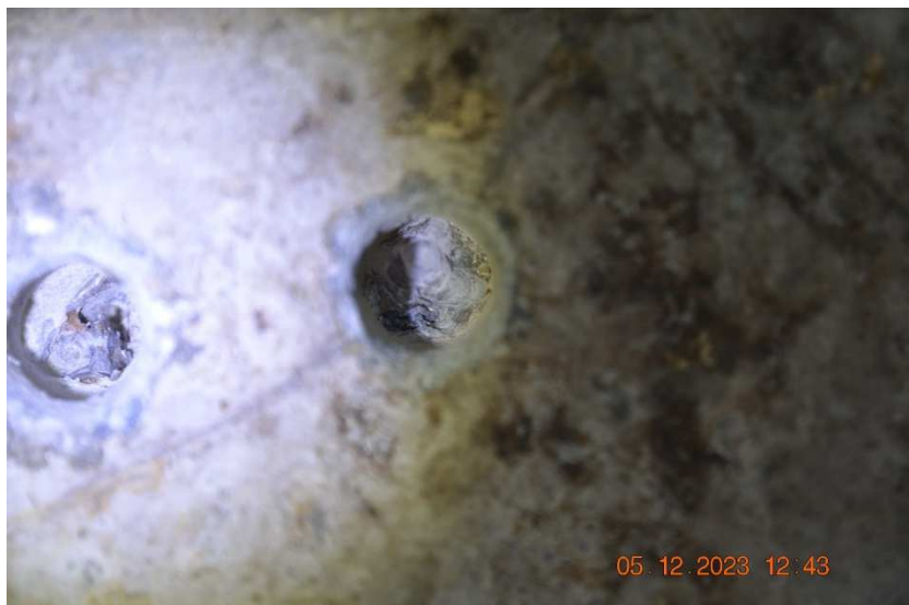
Sondy k předpínací výztuži ve 3. poli (u levého břehu) – kanálky bez koroze a zainjektované.
