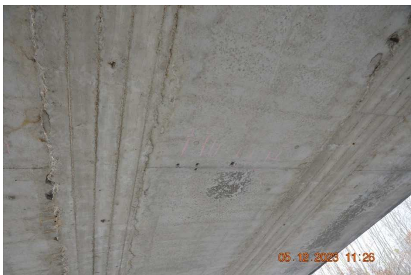
Sondy k předpínací výztuži ve středním poli.
