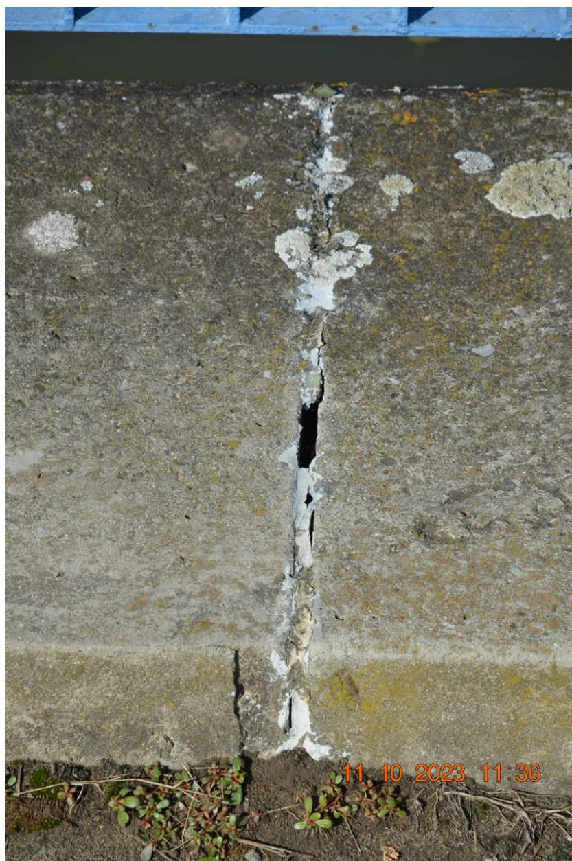
Spáry na římse mezi dílci mají zatmelení původní, úplně špatné. Voda protéká na krajní nosníky.
