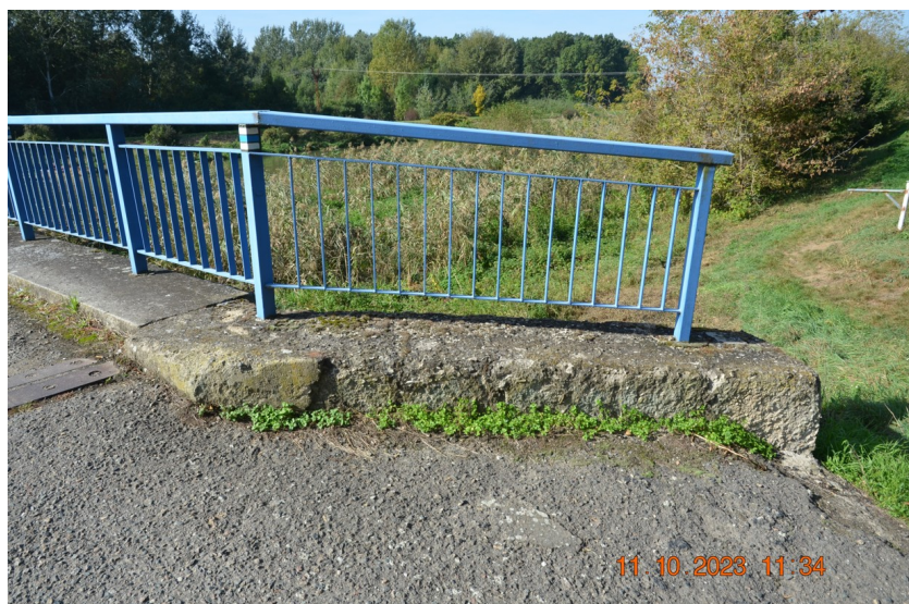
Křídlo u opěry 4 na návodní straně – levý břeh.
