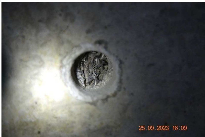
Sonda L4 do podhledu povodního nosníku v 1. poli přímo ve spáře mezi segmenty nosníku I
