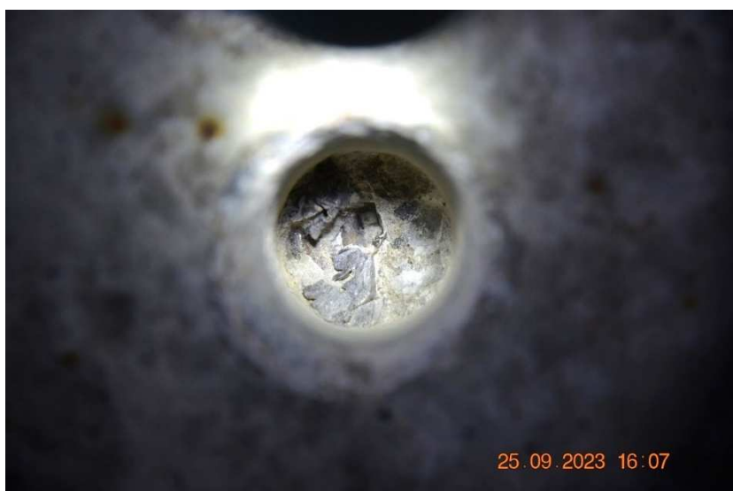
Sonda L2 do podhledu návodního nosníku v 1. poli – kabelový kanálek zainjektován, patentované dráty bez koroze.
