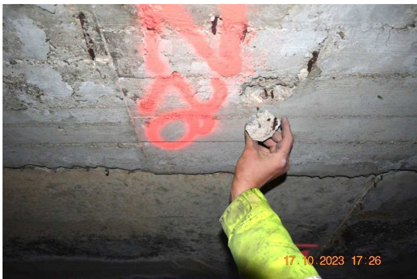
Poškozená spára mezi nosníky v 1. poli
