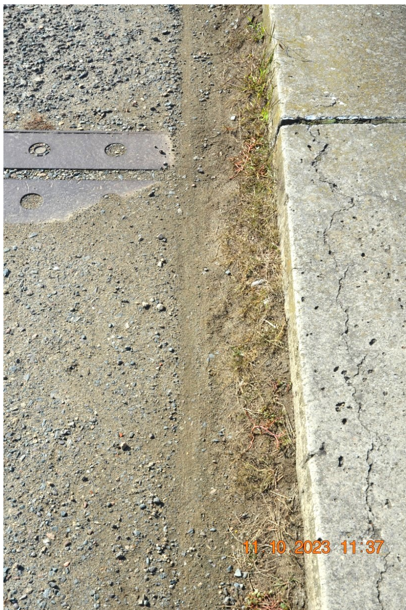
Koroze výztuže římsových dílců je příčinou odražení celé hrany obrubníku – návodní strana.
