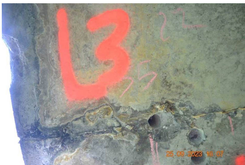
Sonda L3 do podhledu návodního nosníku v 1. poli přímo ve spáře mezi segmenty nosníku I.
