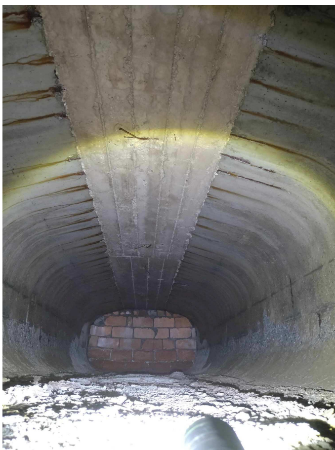
Střední dutina v 1. poli, pohled k opěře 1. Vzadu ztracené bednění pro betonáž koncového příčniku.
