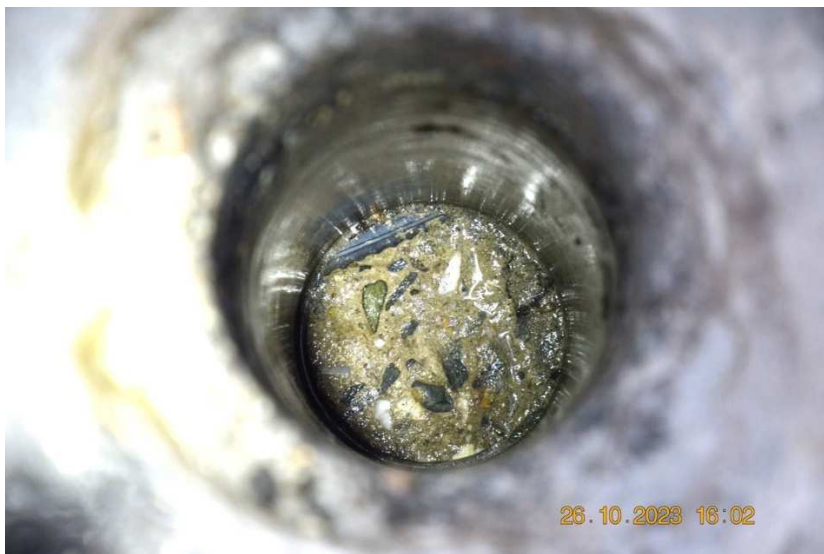
Vývrt H1 ve středu rozpětí středního pole na návodní straně, betonářská výztuž zcela bez koroze.
