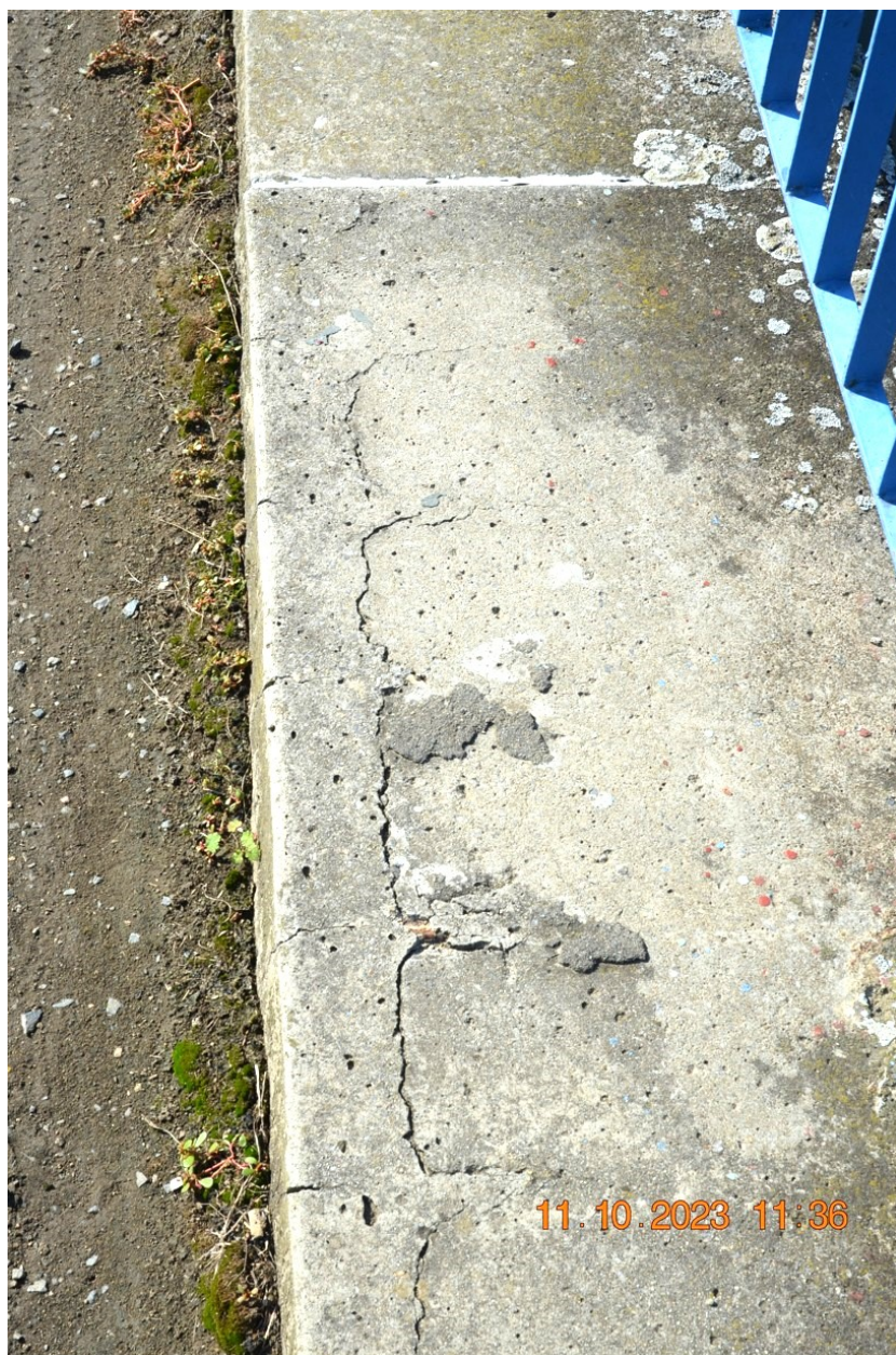
Koroze výztuže římsových dílců – návodní strana.
