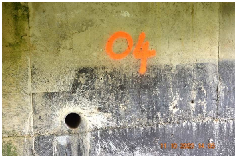
Opěra 4 levobřežní, vývrt do dřívku z prostého betonu.
