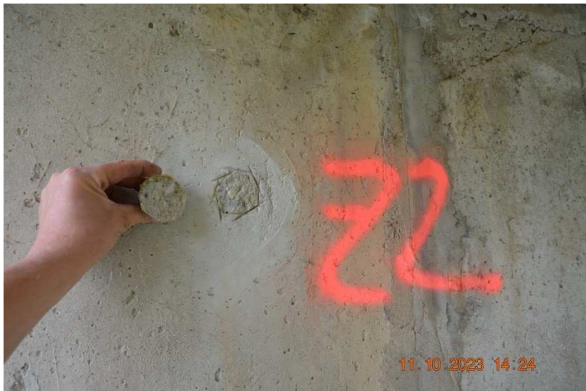
Úl. práh pilíře PI 1 (z 1. pole) – návodní díl A/Y 100 %
