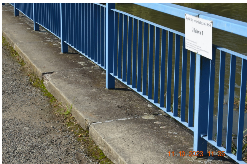
Římky jsou vyskládány z prefabrikovaných dílců.
