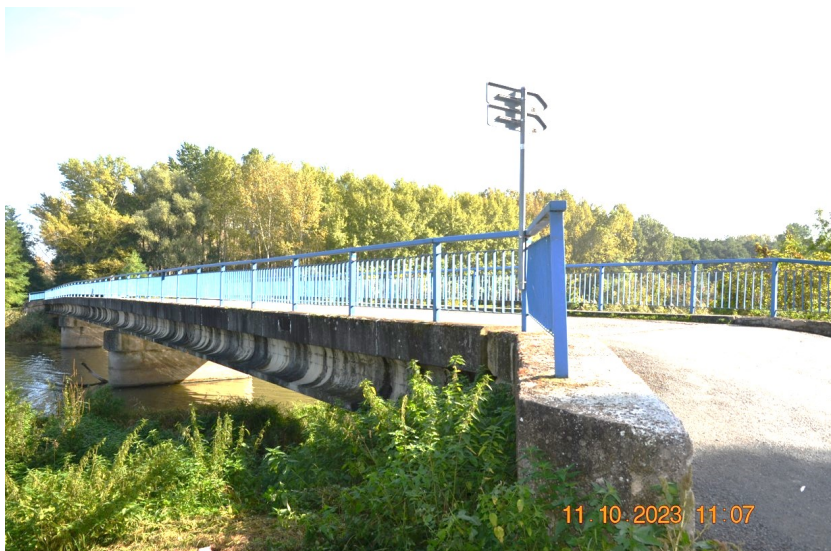
Návodní strana mostu – krajní nosníky jsou potečené vodou ze spár mezi římsovými nosníky.
