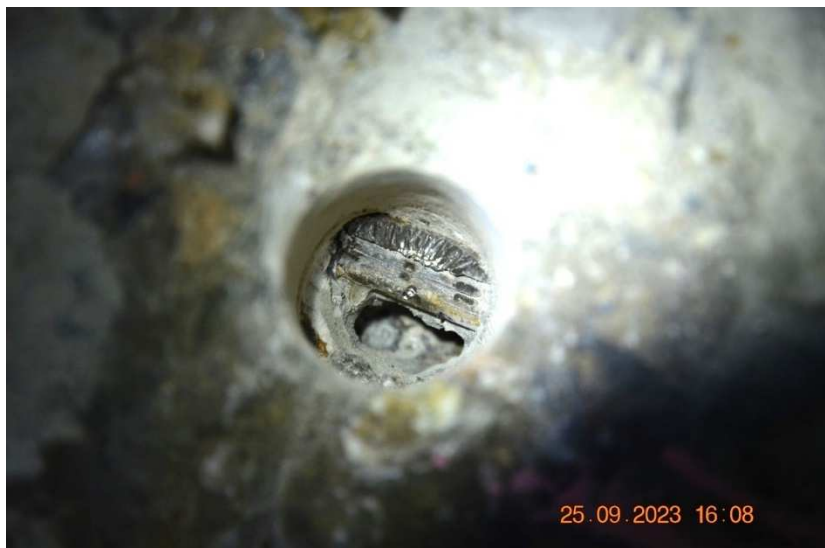
Sonda L3 do podhledu návodního nosníku v 1. poli přímo ve spáře mezi segmenty nosníku I – kabelový kanálek zainjektován, patentované dráty bez koroze.
