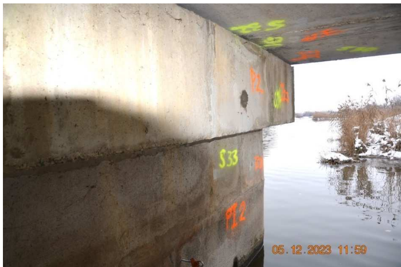
Sondování středních pilířů: P2 vodorovný vývrt do úložného prahu (již zapravený), PI 2 šikmý vývrt dolů do prefabrikovaného dřívku přes vodorovnou spáru pod hladinu vody.
