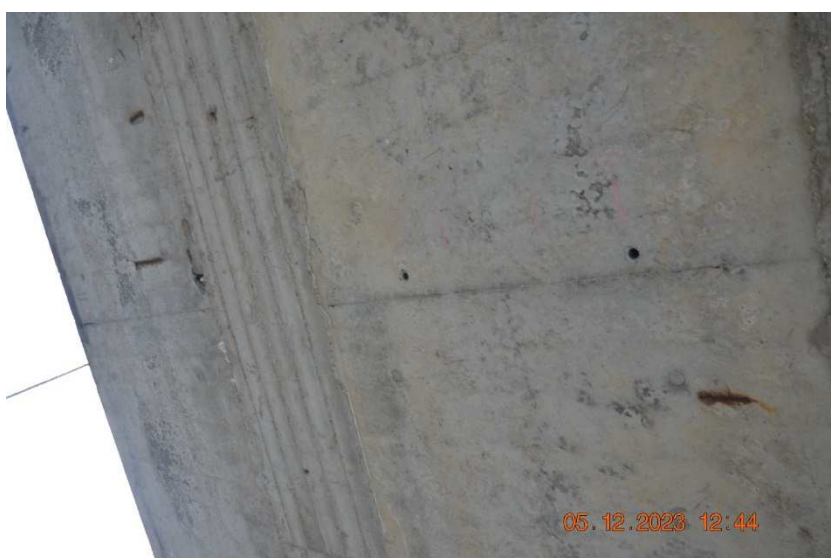
Sondy k předpínací výztuži ve 3. poli (u levého břehu).
