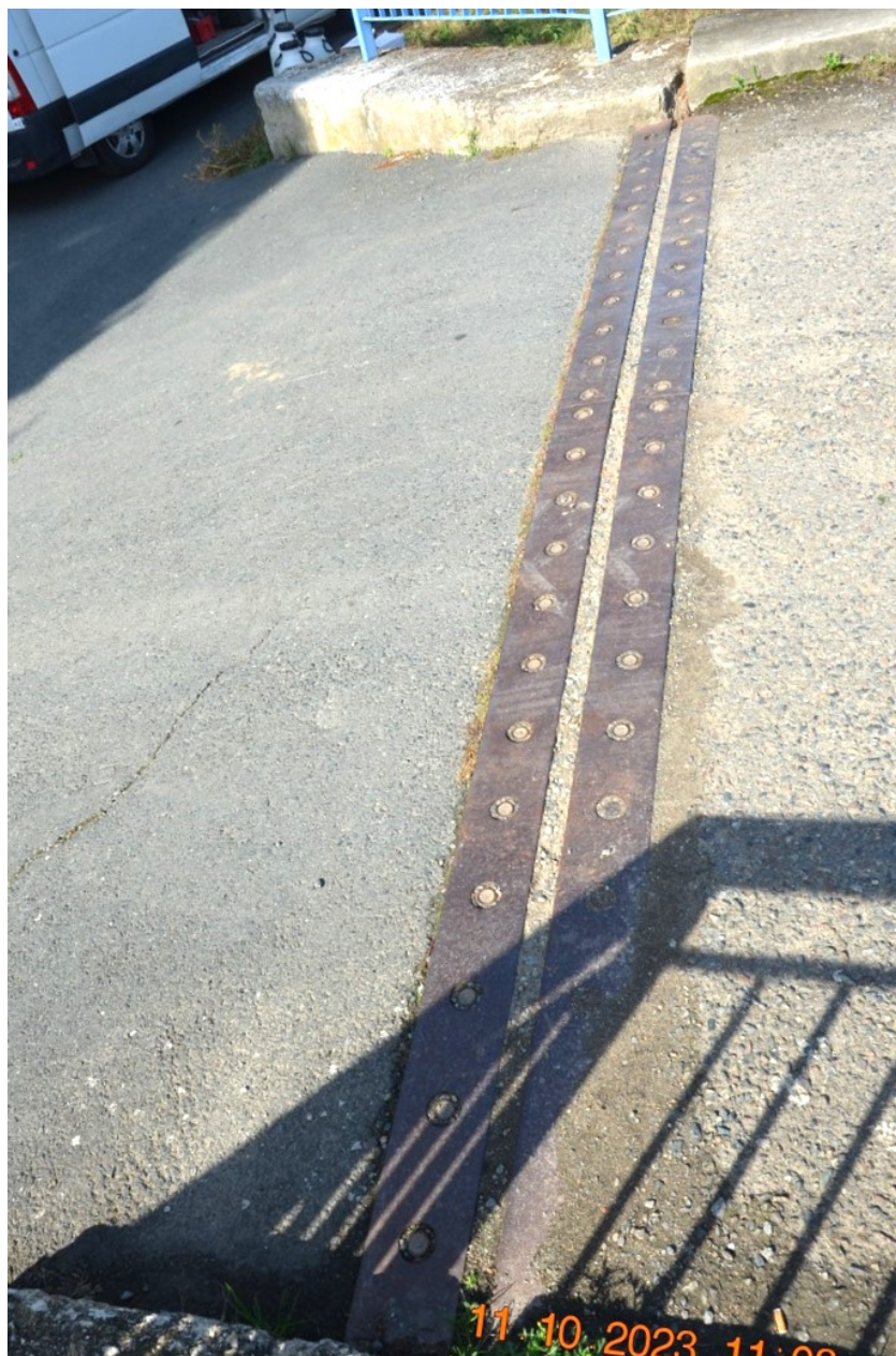
Dilatační závěr nad opěrou 1 – na pravém břehu.
