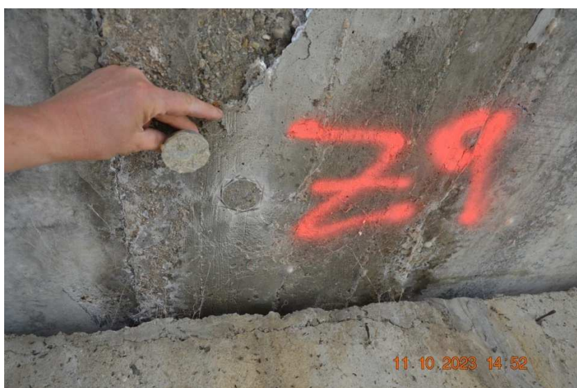
Spára mezi nosníky u pilíře PI 1 ve 2. poli A/Y 100 %.
